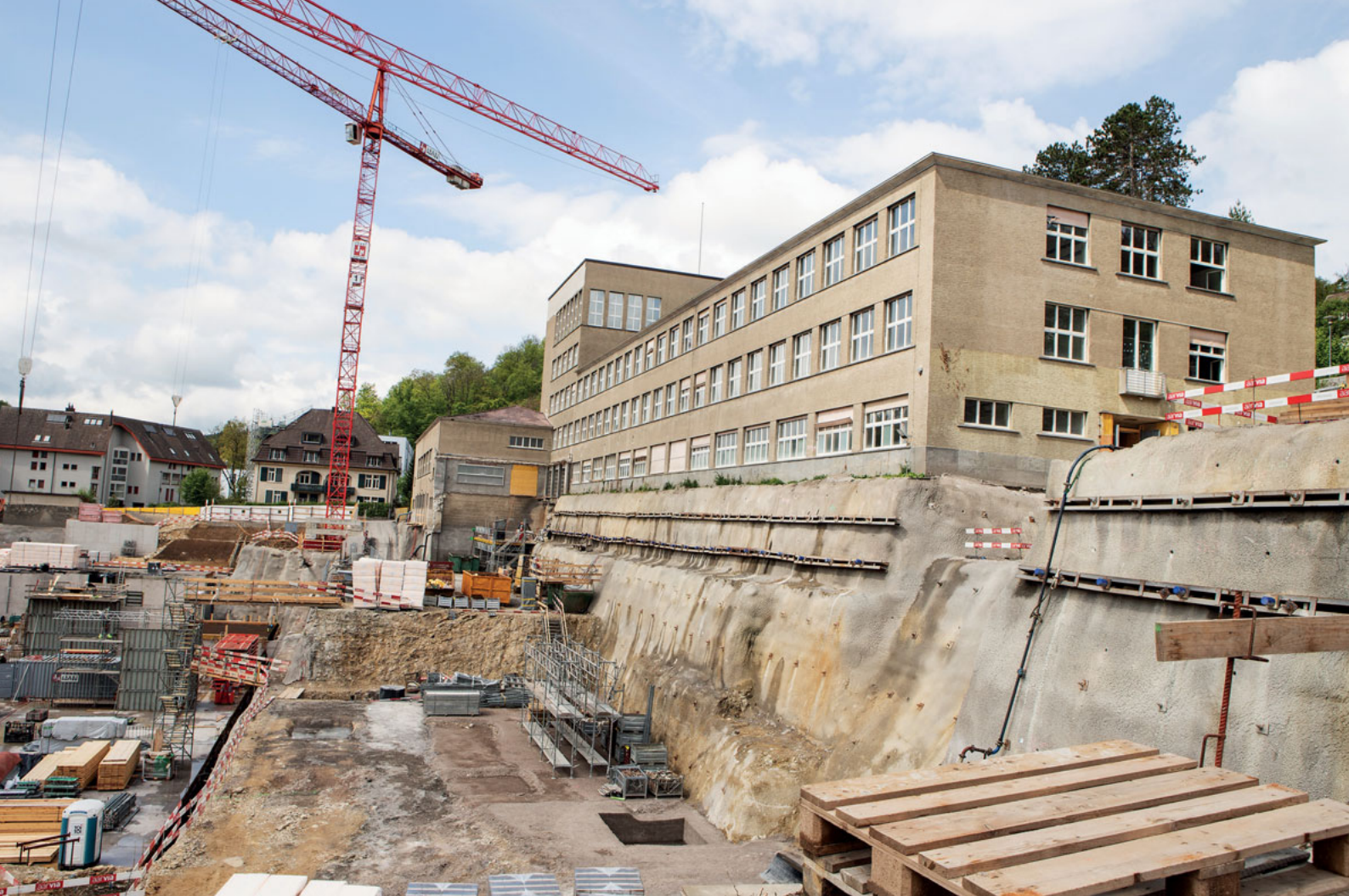
Das Schulhaus Burghalde in Baden aus dem Jahr 1930 wird saniert und grosszügige Neubauten werden dazugestellt.
