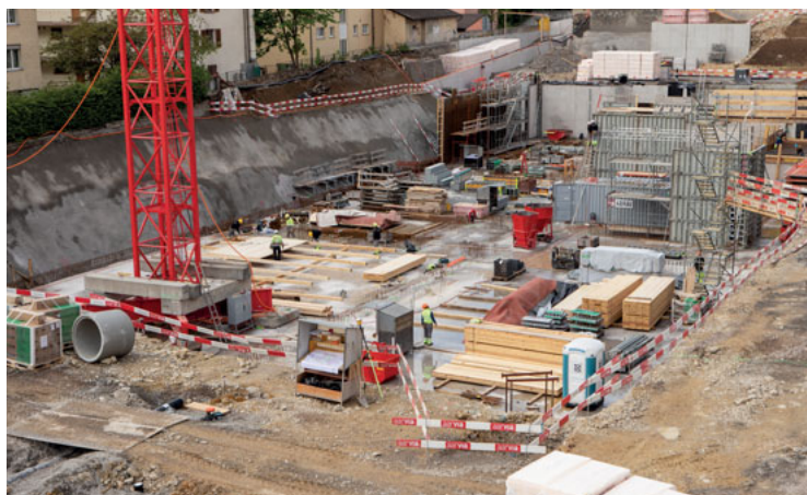
Im Mai 2019 waren etwa 45 Leute auf der Schulhaus-Baustelle – Tendenz steigend.
